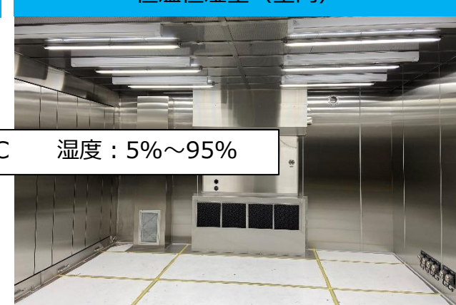
恒温恒湿室（室内）
